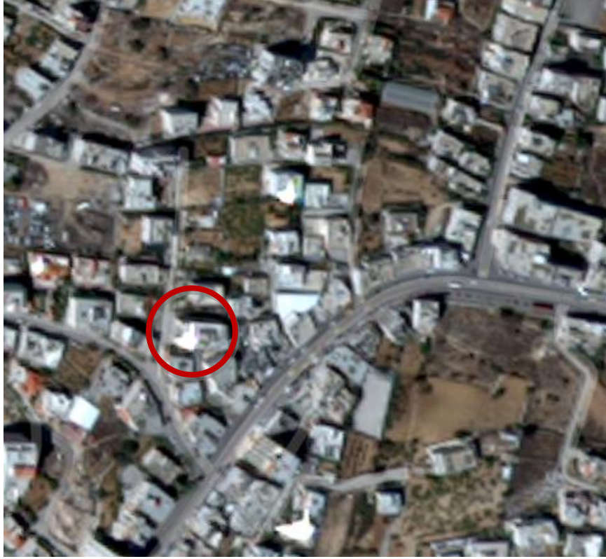
شكل رقم(4-4): صورة جوية لموقع المبنى وعلاقته بالمباني المجاورة
